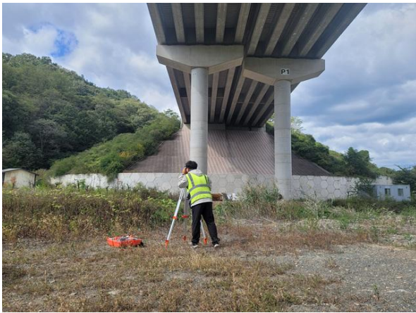
광파기를 이용한 측량 작업사진
